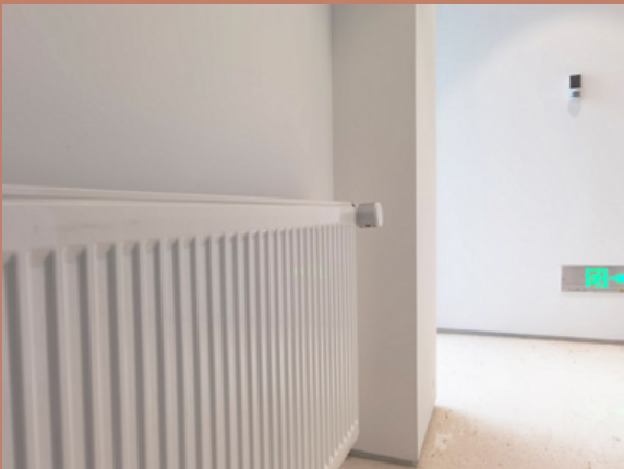
温差能供电的无线无源阀门 执行器及改造展示
